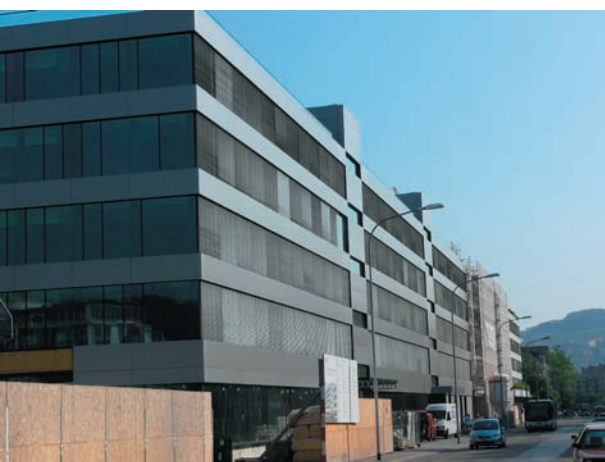
Der Gebäudekomplex UBS Flurhof in Zürich Altstetten wird momentan umfassend saniert Quelle: BUS-House
