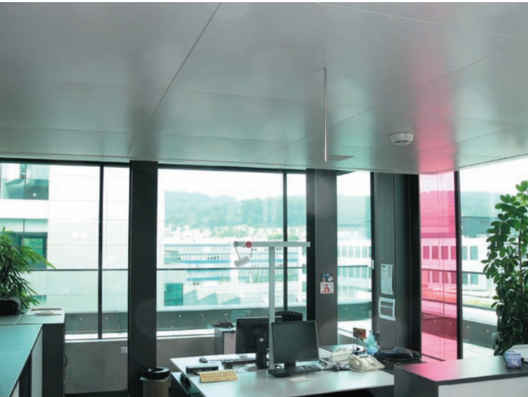
Blick in ein neues, helles Büro. Als einziges sichtbar von der Gebäudeautomation: Raumfühler, aus der Decke ragend Quelle: BUS-House
