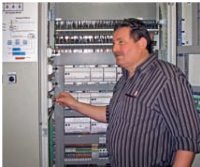
Reinhold Buschle stellt am Fan Optimiser die Parameter \dot{V}_{MIN} und \dot{V}_{MAX} der Volumenstromregler ein.
